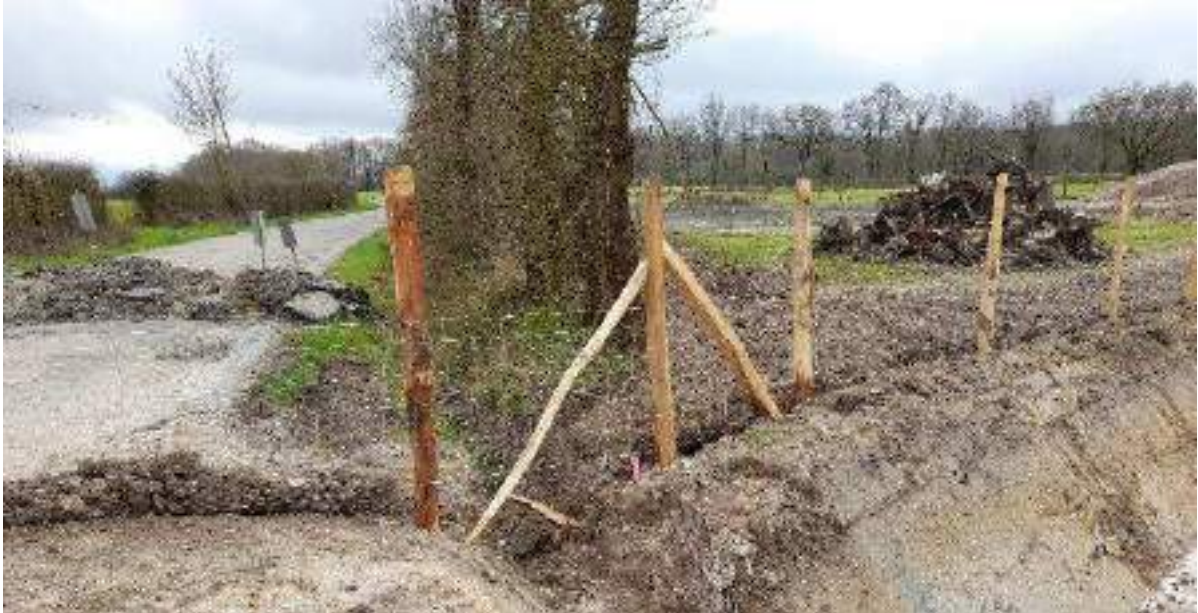
Figure 8. Illustration de mise en défens en phase chantier
