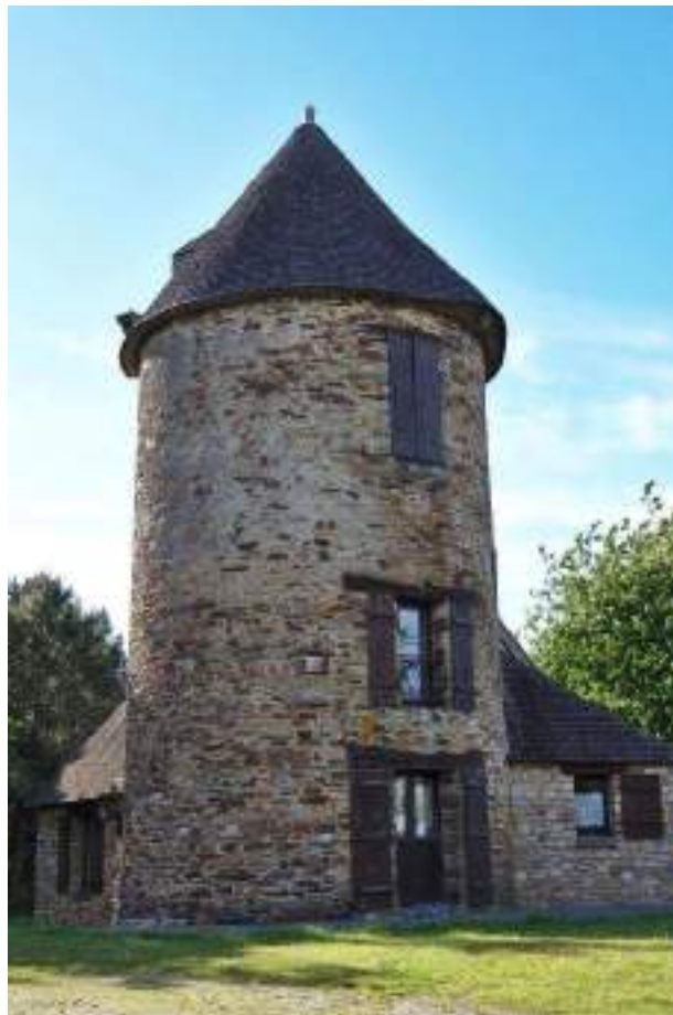
Figure 29 : Élément bâti à protéger du PLUi de Bretagne Porte de Loire Communauté : Moulin de Pomméniac
